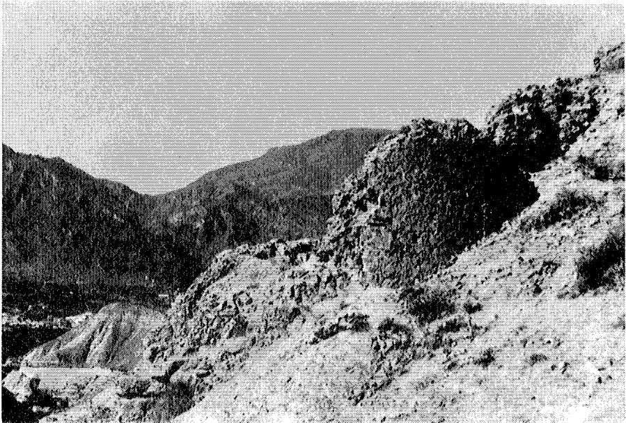
Lám. 2.— Torreón en un ángulo de la fortaleza. Obsérvese el muro que la prolonga hasta formar la barbacana. Al fondo, Huéctija.
